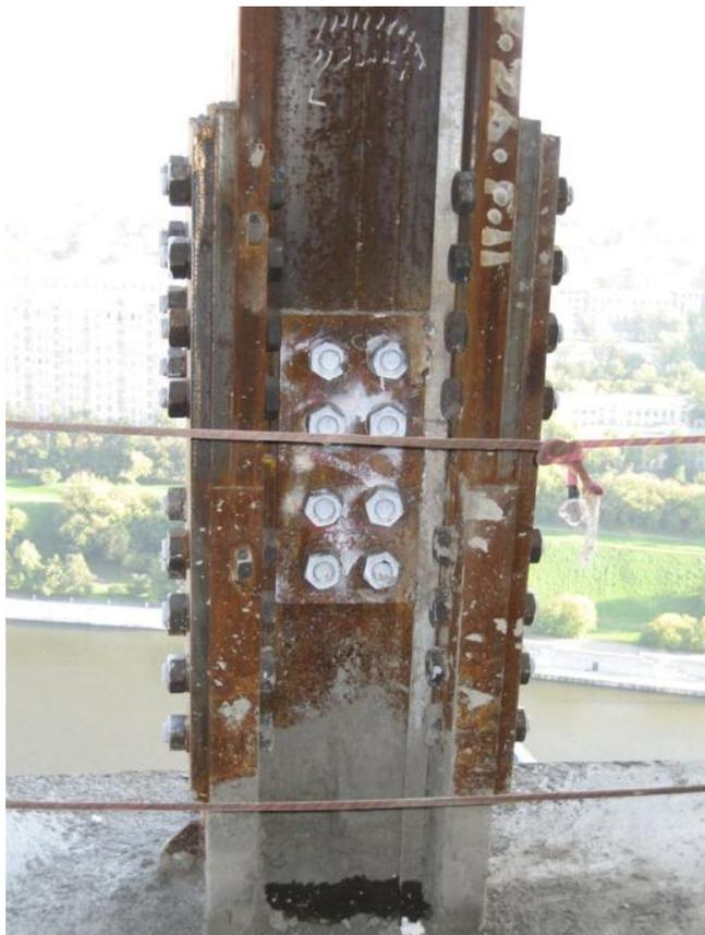
▲ Болтовой стык прокатной колонны обстройки здания на участке №10
