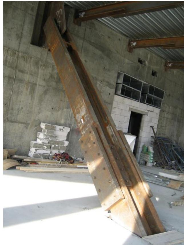
▲ Подкос двухэтажного аутригера на 28 этаже здания на участке №12 (видны монтажные болты на накладке и разделка кромок для сварки)
